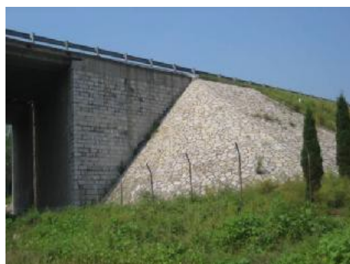
图 2.3-2 (4) 桥头浆砌片石防护
