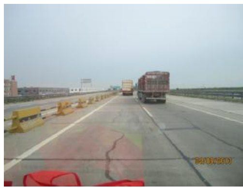
图 2.3-4 (2) 中央分隔带铺砌破坏
