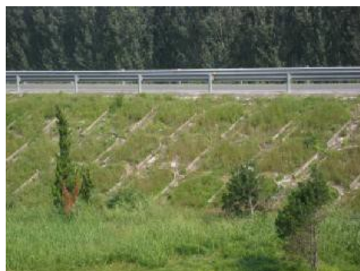
图 2.3-2 (2) 拱形骨架防护
