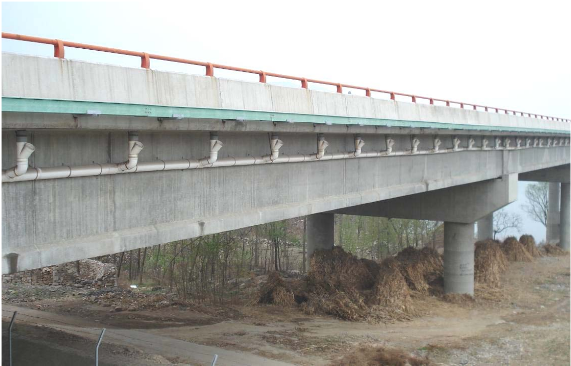
图 7.5-2 径流收集系统实景照片
